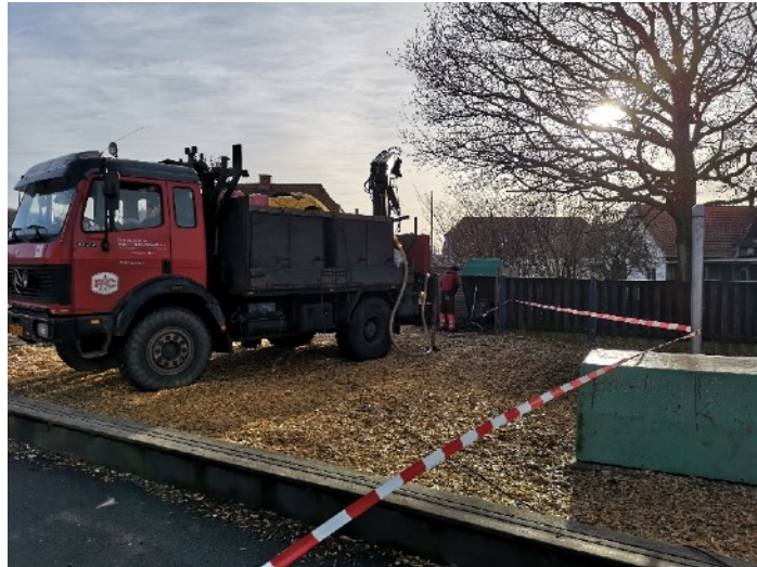
Brøndboren er i gang med at udskifte dykpumperne
